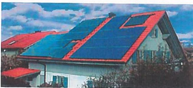
Vier der fünf Beispiele entsprechen den vorliegenden Empfehlungen: oben entsprechend der Dachneigung; in der Mitte als schräg abfallende Indachanlage und senkrecht an der Fassade verteilt. Auf dem Bild unten rechts hingegen sind die Kollektorfelder unsymmetrisch angebracht: Die Anordnung wird als «störend» empfunden.
