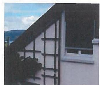
Hier sind die Hin- und Rücklaufleitungen des Solarkreislaufs im Dachabflussrohr untergebracht, das so aussieht, als wäre es immer da gewesen.
